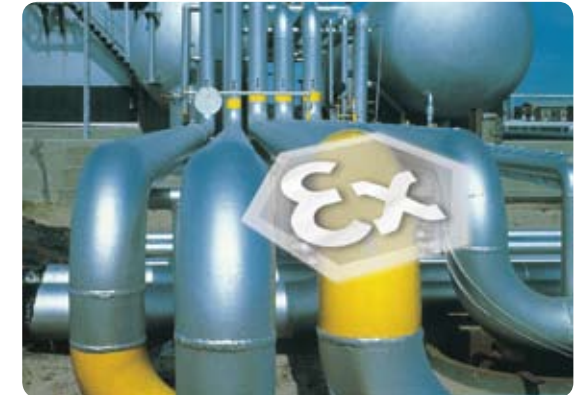
RFID eröffnet viele neue Chancen, ob bei der Überwachung an Schlauchbahnhöfen, Kennzeichnung von Anlagenteilen oder Wartung von Bohrgestängen oder Pipelines.
