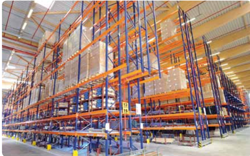
Von SSI Schäfer realisierte Breitgananlage mit Bereitstellplätzen bei Big Dutchman International, Vechta.
